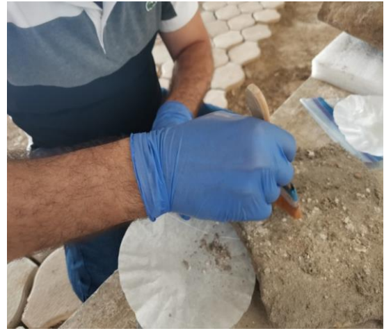
صورة رقم (2) التنظيف بواسطة الفرشاة
